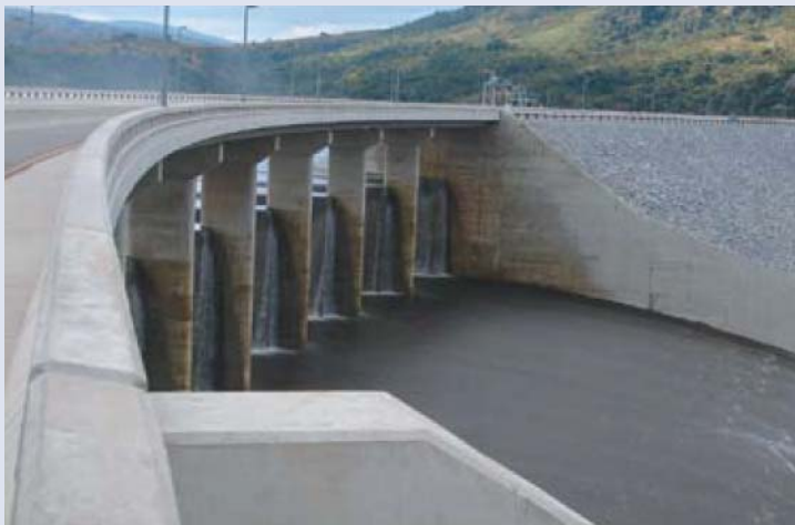
Represa Maguga, un ejemplo inusualmente exitoso de reasentamiento para la construcción de una represa. Fotografía: Liane Greef
