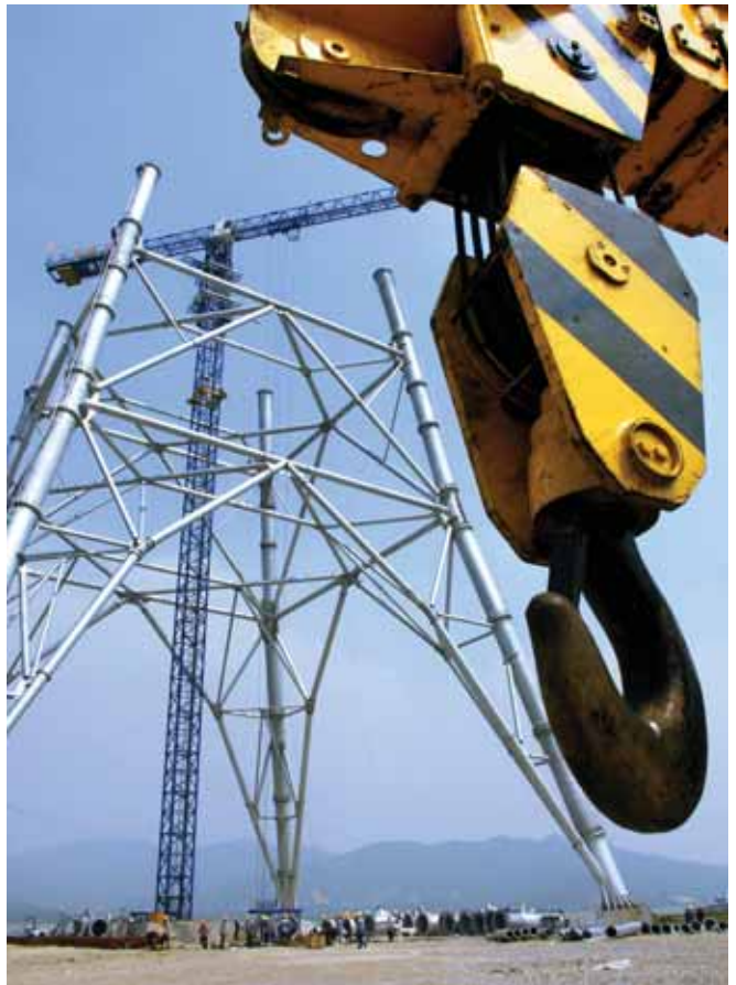
500千伏跨江铁塔建设
